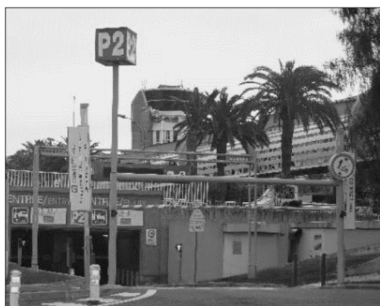
Photo de l'entrée du parking P2 situé au terminal 1 de l'aéroport – Source Sareco
