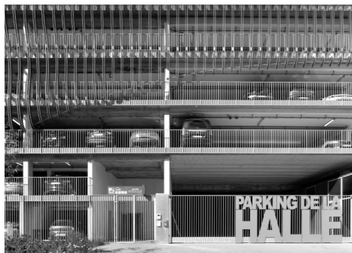
Illustration : parking silo de la Halle à Saint Ouen, Architectes : Reichen et Robert & Associés, MOA : Sequano aménagement, Photographie : Camille Gharbi
